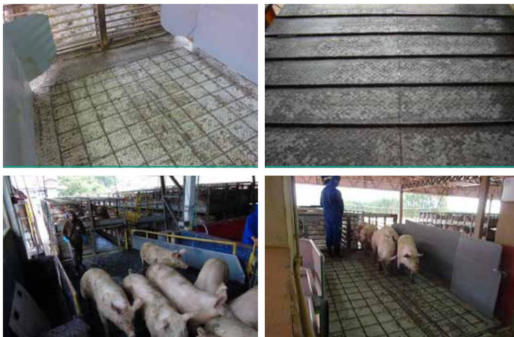
Figura 2. Rampas com piso antiderrapante (metálico riscado xadrez, com grades no piso, emborrachado) e angulação adequada.
